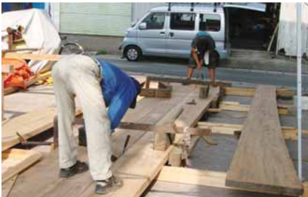
棟梁と技術継承に挑戦する若者の矧ぎ合わせの作業の様子です。
